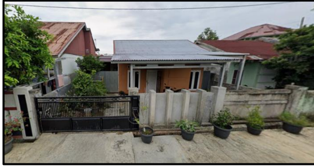
Gambar 4. Modifikasi Fasad Rumah Tinggal dengan Penambahan Teras di Perumahan Al-Kautsar Sukarami, Kota Bengkulu Sumber : Google Street View, 2026
