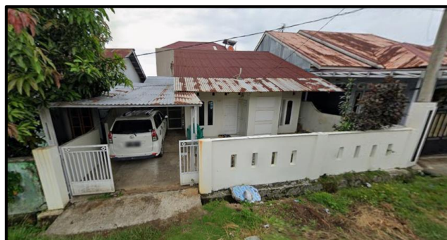
Gambar 3. Modifikasi Fasad Rumah Tinggal dengan Penambahan Kanopi/Garasi di Perumahan Al-Kautsar Sukarami, Kota Bengkulu
