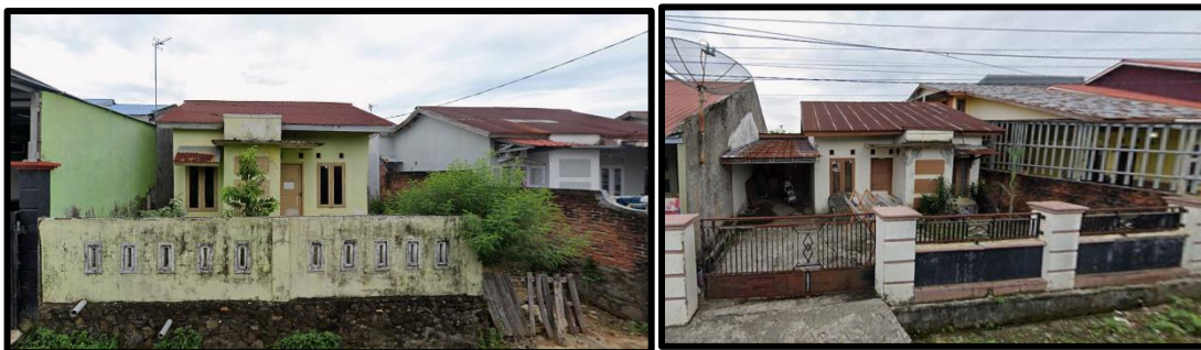
Gambar 1. Foto Eksisting Rumah Tinggal Asli di Perumahan Al-Kautsar Sukarami, Kota Bengkulu Sumber : Google Street View, 2026
